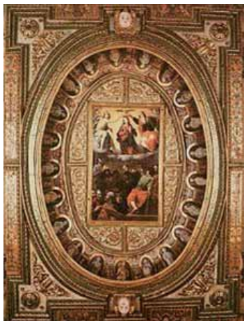
Fig. 1 Soffitto a cassettoni di San Gregorio Armeno (NA) con particolare dei volti degli angeli restaurati con schiume poliuretaniche.
