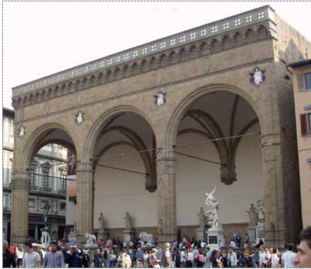
Fig. 1 Firenze, Loggia dei Lanzi (1376-1382): Arenaria trattata con derivati perfluoropolieteri e con perfluoropolimeri.
