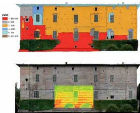
Fig. 1 Analisi stratigrafica delle fasi storico evolutive della facciata nord, cross-correlate alle indagini termografiche per la valutazione delle dispersioni termiche. Stratigraphic analysis of the historical stages of the north wall, cross-related with thermographic investigations for the heat losses evaluation.
