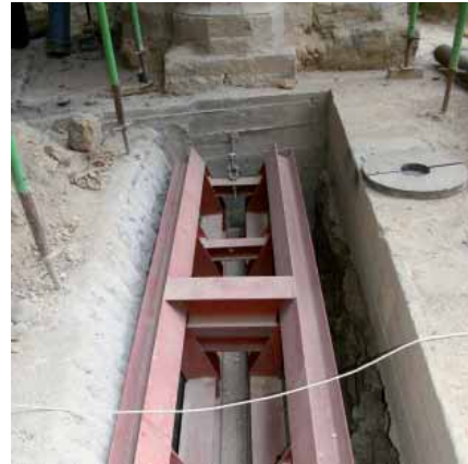
Fig. 2 La zavorra metallica in grado di oscillare, utilizzata per realizzare il pendolo durante i lavori di consolidamento del Bedestan ex chiesa St. Nicholas, a Cipro.
